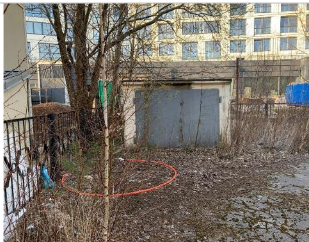
Фотография 3.1. Внешнее состояние объекта
