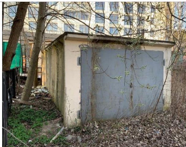
Фотография 3.2. Внешнее состояние объекта
